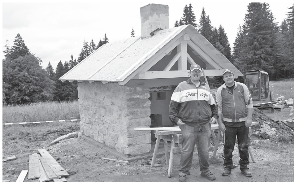
Manuel Weber und Tobias Fett (v.l.) von den Wolfsteiner Werkstätten vor dem fast fertiggestellten Backofen
