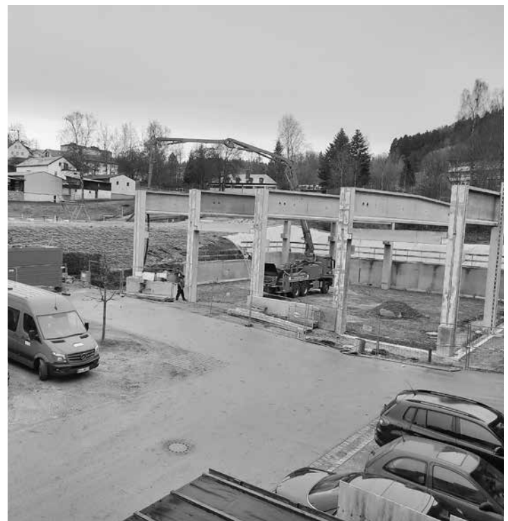
^ Verfüllen der Fertigteile mit Einsatz einer Betonpumpe
