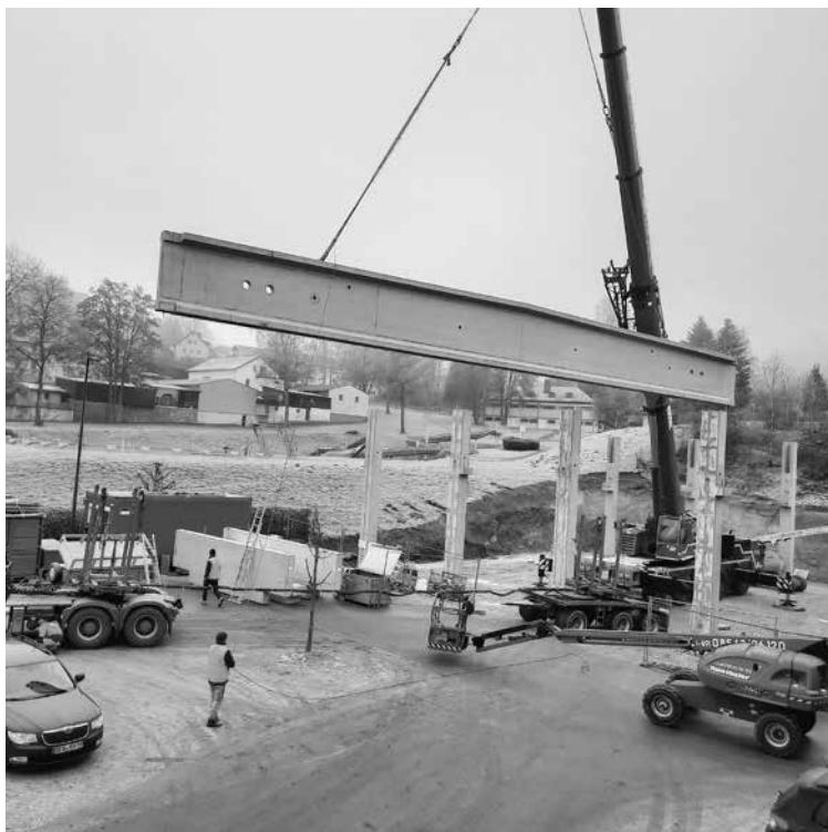
^ Per Autokran werden die Beton-Fertigteile an Ort und Stelle gehoben
