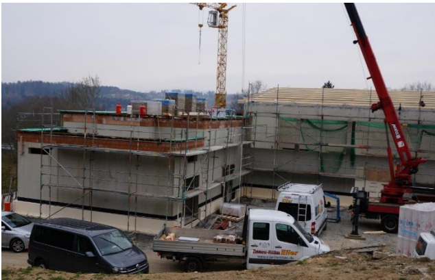
Stets informiert – Baustellen-Besichtigung an der Caritasschule St. Elisabeth
